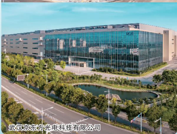
创维武汉Mini LED显示科技产业园
