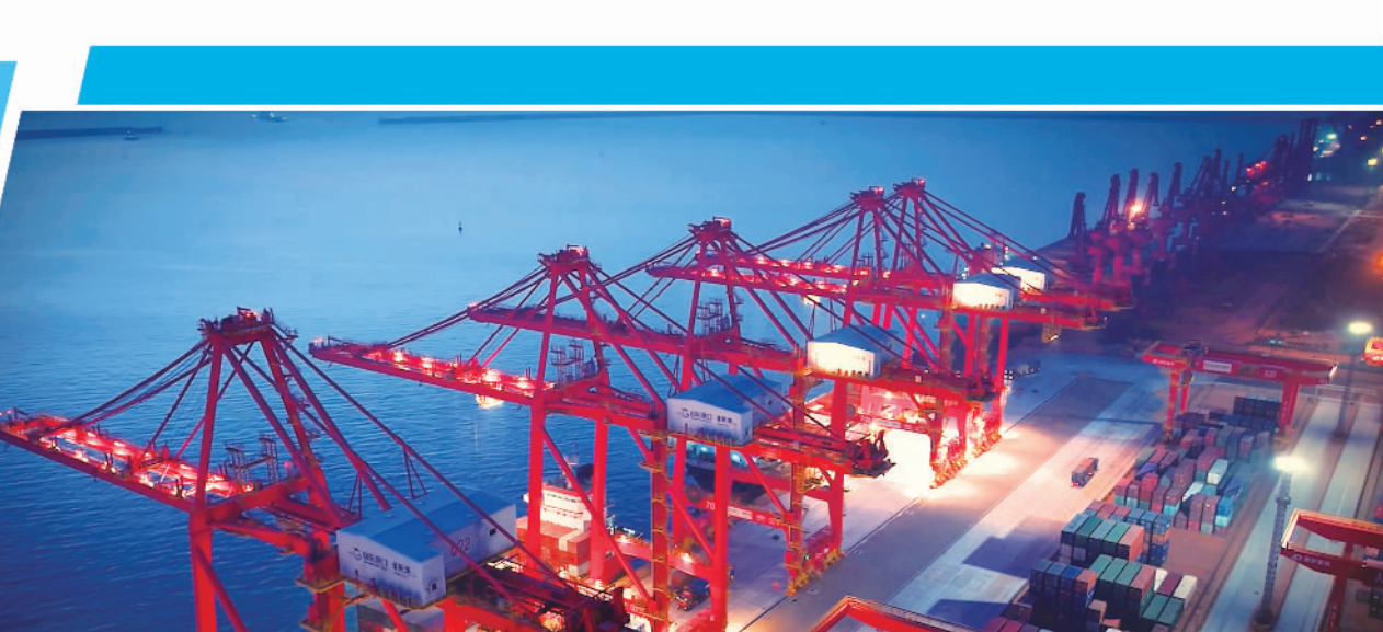
山东港口日照港码头
