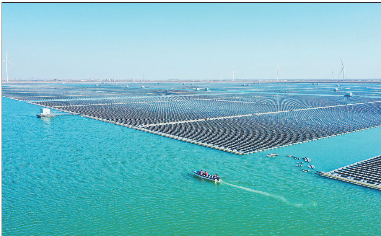
山东德州丁庄水库水面面积8899亩，其中7000余亩用于光伏发电项目。相比传统陆地光伏电站，水面漂浮式光伏电站具有节省基础成本、施工周期短等优势，可减少水体蒸发量，利用水面冬暖夏凉的特点可提升发电效率。图为当地电力员工乘船在丁庄水库光伏项目协助排查安全隐患。宋伟龙摄(影像中国)
