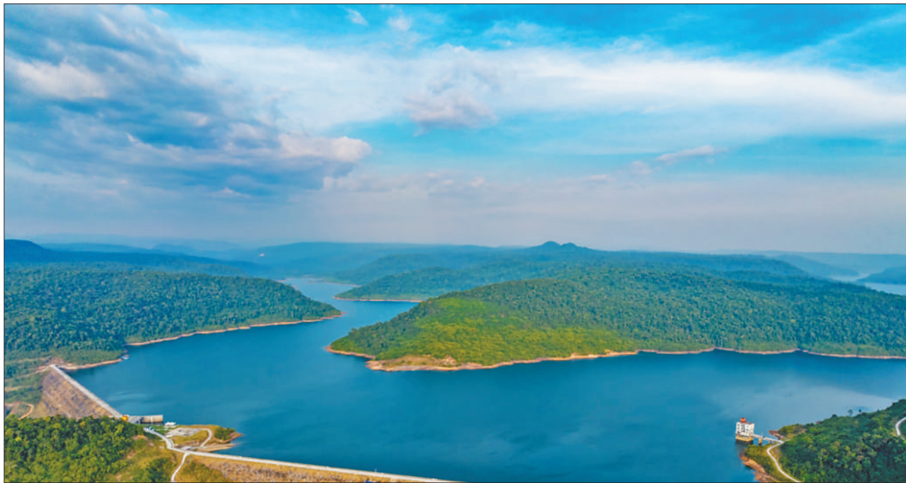
上图：达岱水电站库区。 曾阳洋摄 左图：上达岱水电站项目施工人员在修理机械设备。 本报记者 刘慧摄
