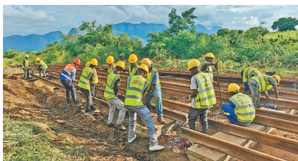
维养工人正在纳卡拉走廊铁路PK433路段进行混凝土轨枕安装工作。 涂磊摄 制图：蔡华伟
