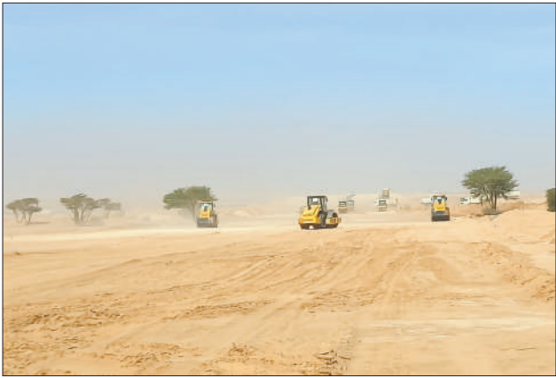
项目路基填方施工现场。
