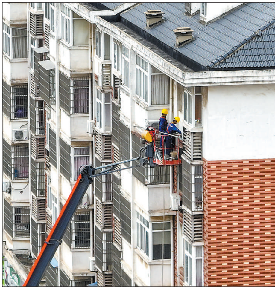
江西省九江市湖口县某老旧小区改造现场，工人在对小区燃气管道进行改造。
