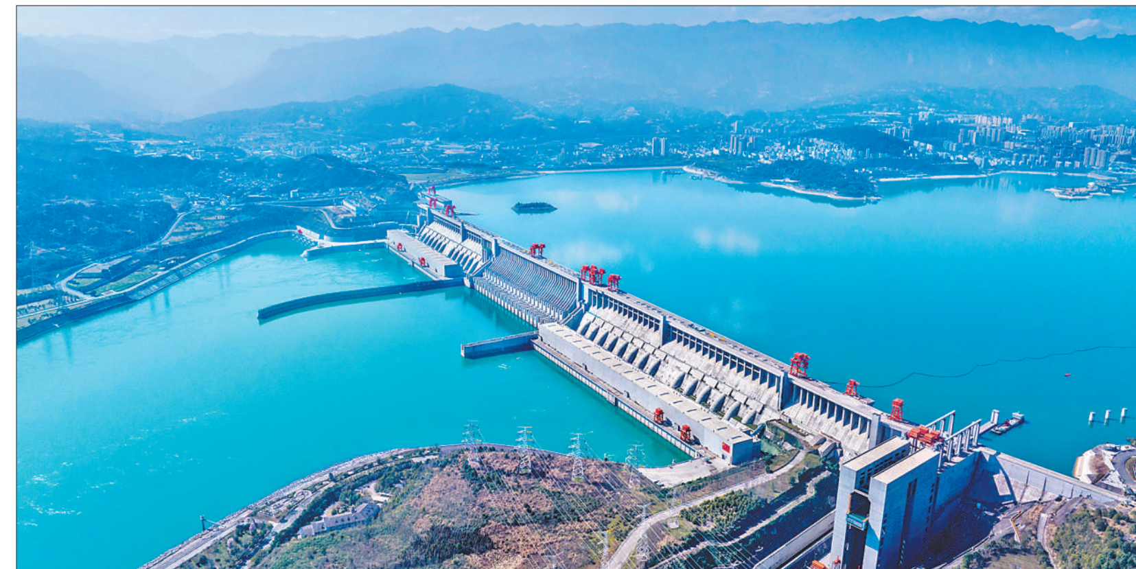
截至2月16日24时,世界最大清洁能源走廊六座梯级电站(乌东德、白鹤滩、溪洛渡、向家坝、三峡和葛洲坝)累计发电量突破3.5万亿千瓦时,相当于节约标准煤超10亿吨,减排二氧化碳超28亿吨,为经济社会绿色发展提供强劲动能。图为位于湖北省宜昌市秭归县的三峡大坝及输电设施。郑坤摄(影像中国)
