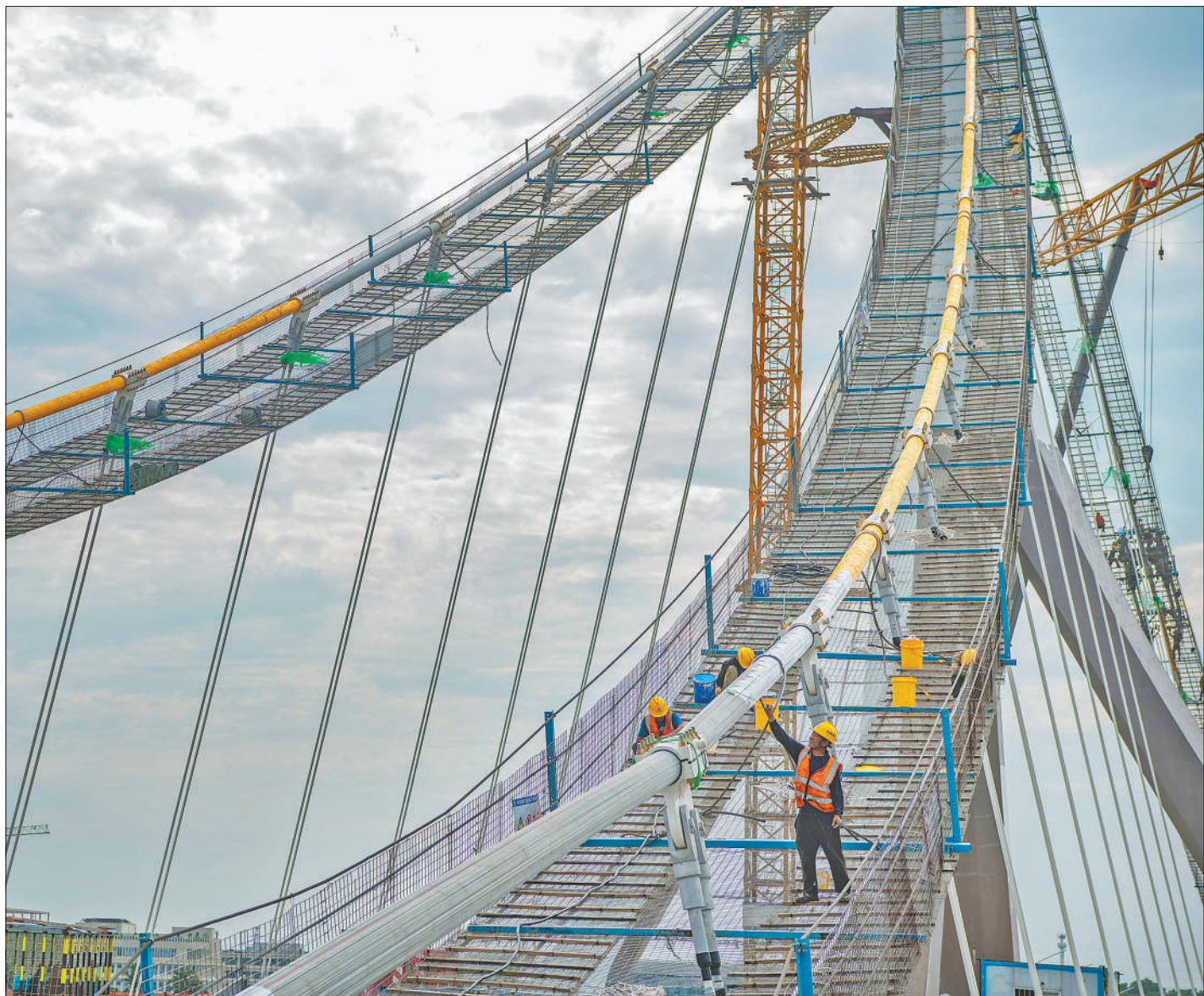
2月18日,海南省琼海市,建设工人在乐城大桥上加紧施工。据介绍,海南首座悬索桥乐城大桥是海南重点建设项目,目前大桥已完成主缆架设,进入建设最后冲刺阶段。 董钟德摄(影像中国)
