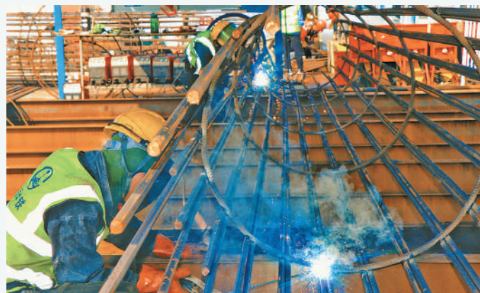
工人在沪苏嘉城际铁路上海青浦朱家角段现场施工。沪苏嘉城际铁路建成后,可加强示范区内及与各地主城区间的快速联通。
