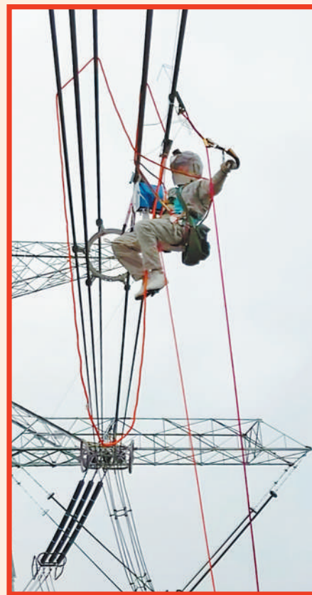
▲ 湖北广水市长岭镇，国网湖北超高压公司员工在进行高空作业。 孔韬摄(人民视觉)
