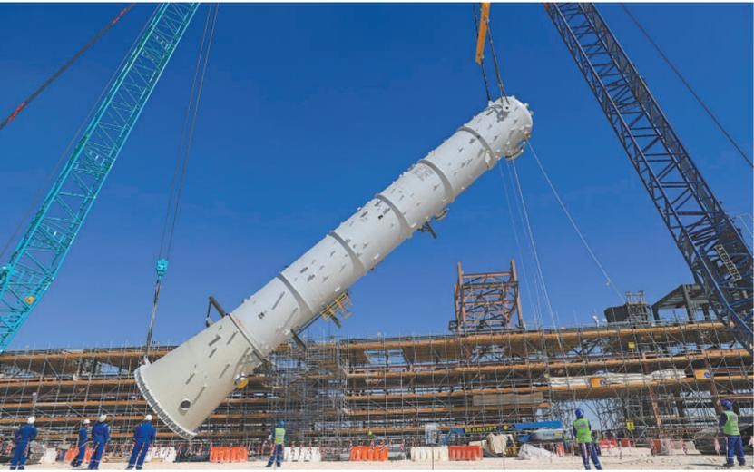
▲阿联酋巴布油田综合设施项目建设期间,工作人员在安装新型脱气塔。
