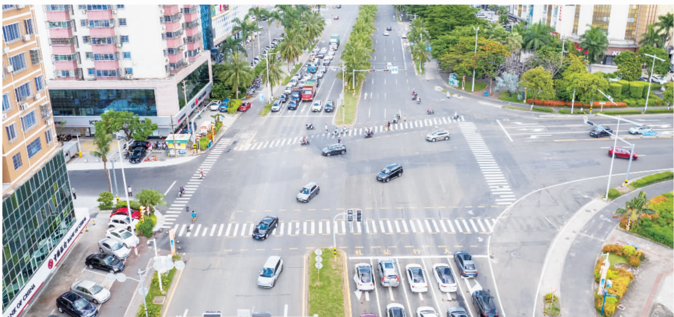
海口海港路与滨海大道交汇路口的积水点完成改造
