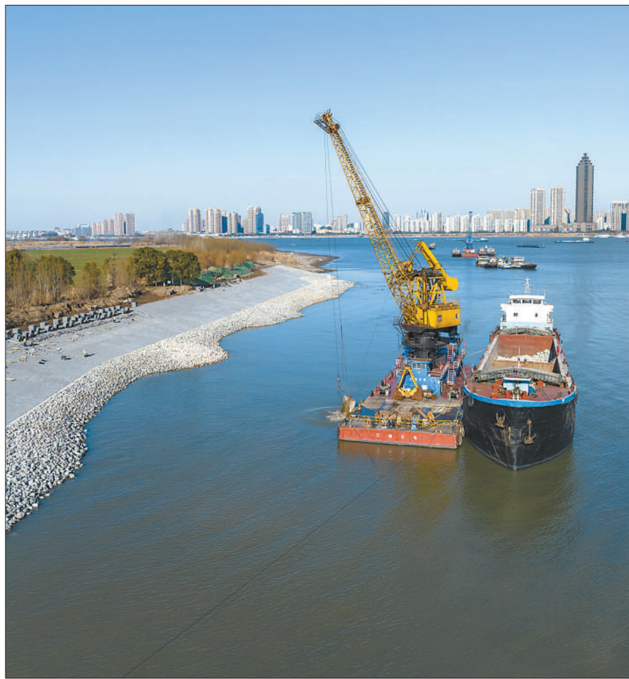
安徽省芜湖市鸠江区长江芜湖河段整治工程建筑工地，工作人员在进行抛石护岸施工作业。
