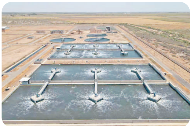
苏维拉污水处理厂全景。张清摄
