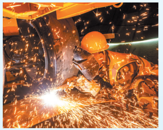
珠江三角洲水资源配置工程内衬施工阶段,建设者在隧洞内进行钢管焊接作业。 梁海沛摄(人民视觉)
