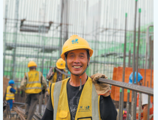
珠江三角洲水资源配置工程鲤鱼洲泵站,建设者在搬运钢筋。 欧盛满摄(人民视觉)
