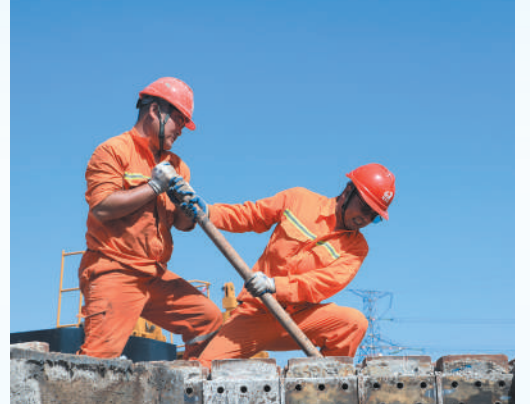
珠江三角洲水资源配置工程盾构隧洞贯通后,建设者合力拆除盾构机刀盘。 关伟俊摄(人民视觉)
