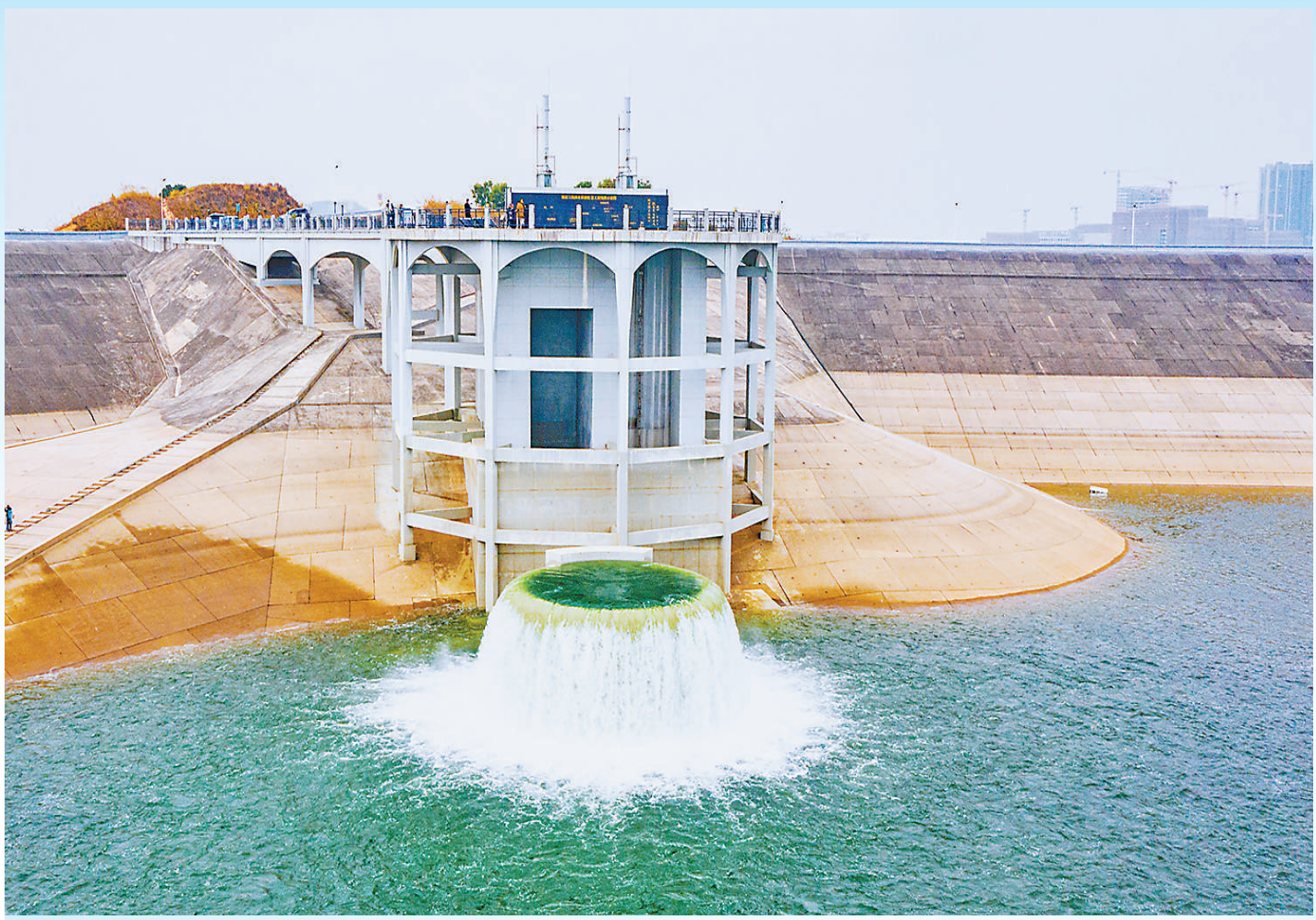
1月30日,珠江三角洲水资源配置工程公明水库交水点迎来西江水。
