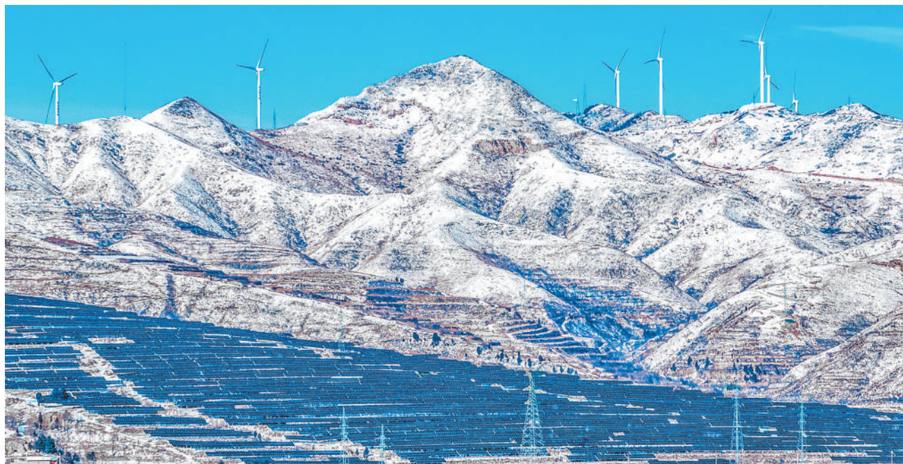
近年来,山西省运城市大力发展绿色低碳产业,通过对风、光、生物质等可再生能源的综合利用,有效减少煤炭等化石能源消耗,推动能源结构进一步转型。图为运城市芮城县一处光伏基地的光伏面板整齐排列。 薛俊摄(人民视觉)
