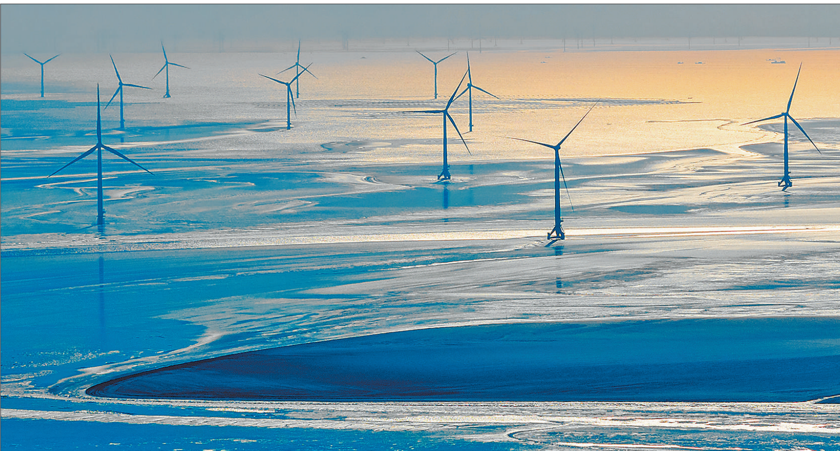
近年来,江苏省东台市充分发挥沿海滩涂的风能、光能等优势,推进陆上风电、海上风电等清洁能源产业发展,加快规划建设新型能源体系,持续推进立体式、集约化开发。图为近日位于东台市条子泥海滨的风电场一景。
