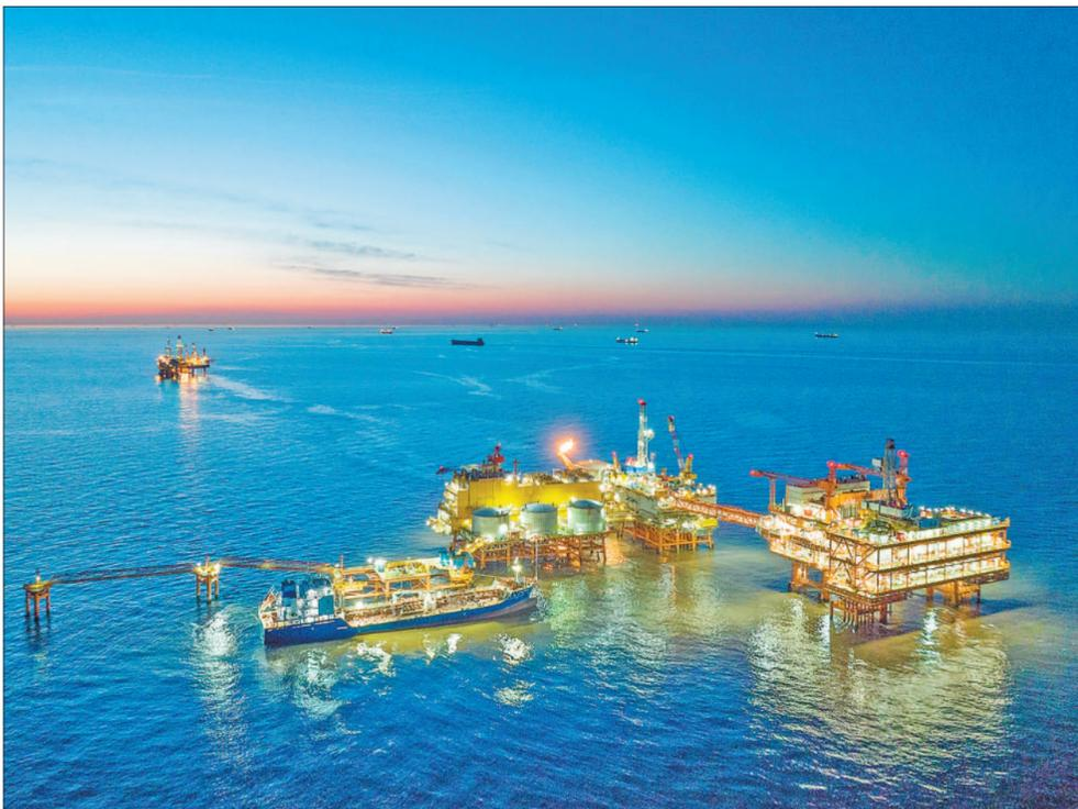
1月25日,位于渤海湾西南部的埕北油田油气处理与岸电设备共建平台——CEPC(中心平台)正式投产,该平台可使油田接入来自陆地的绿色电力,减少海上“自发电”带来的天然气和原油消耗。图为当日拍摄的埕北油田CEPC(右)。
