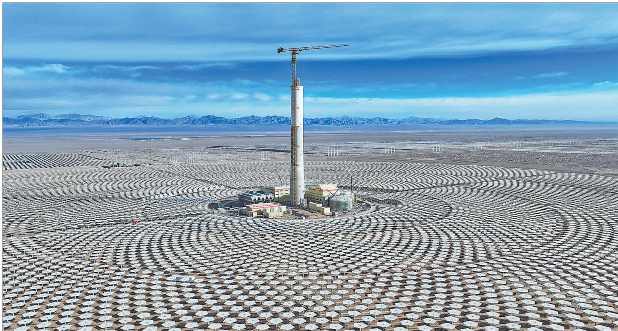
1月23日,甘肃省酒泉市阿克塞哈萨克族自治县汇东新能源“光热+光伏”试点项目的11960面定日镜全部安装完成,项目建设稳步推进。项目建成后,预计年发电量将达17亿千瓦时。
