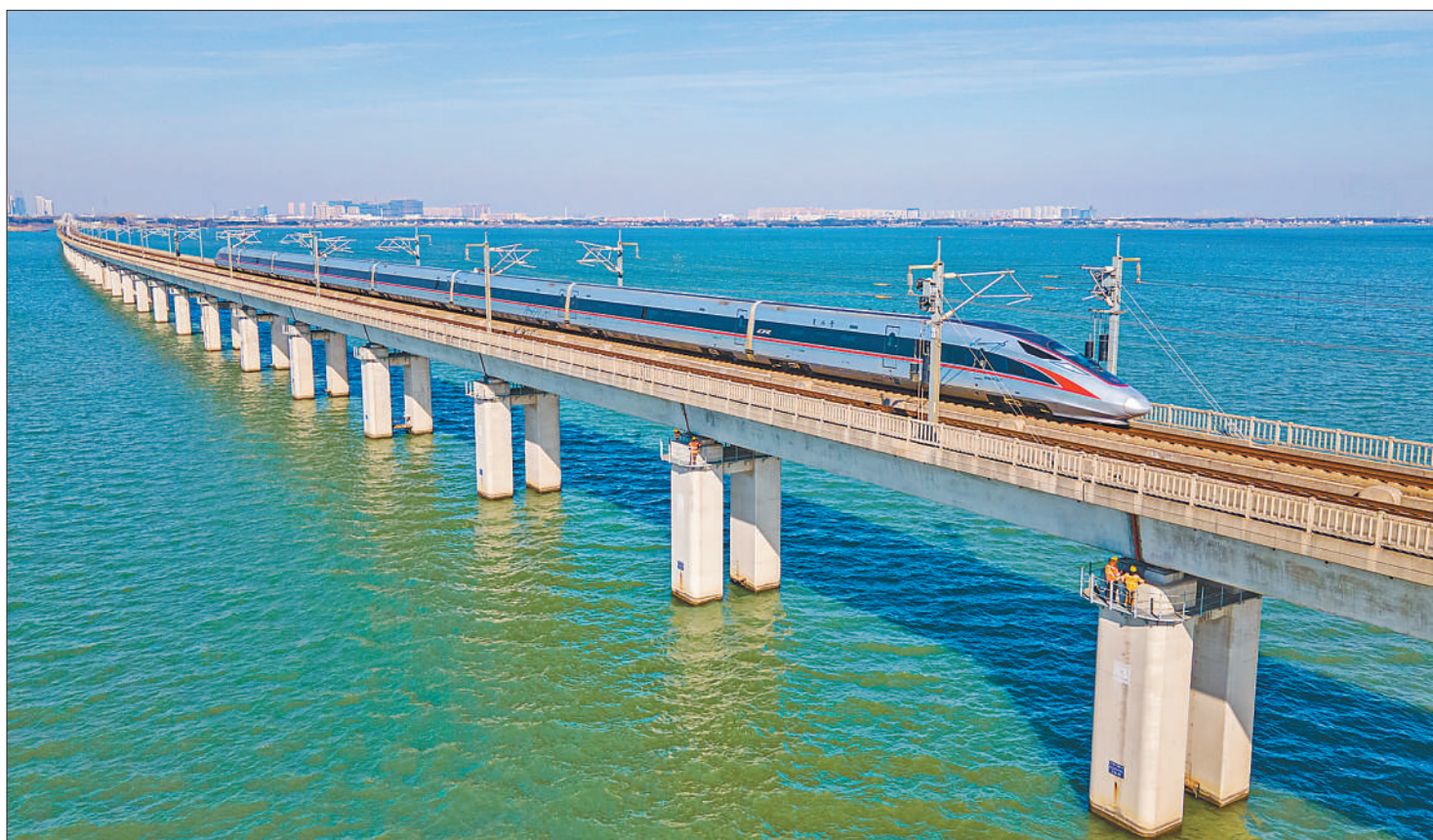
1月24日，在江苏苏州，中国铁路上海局集团有限公司上海高铁基础设施段苏州北综合维修车间检查工区的高铁综合维修工，正在对丹昆特大桥进行检修维护。据了解，丹昆特大桥位于京沪高铁江苏段，从桥头到桥尾的距离穿越5座城市，全长164.851公里。春运将至，高铁综合维修工对桥墩支座结构、梁内混凝土结构及排水设施等关键部位逐一进行检查，以确保列车平稳运行，护航春运回乡路。
