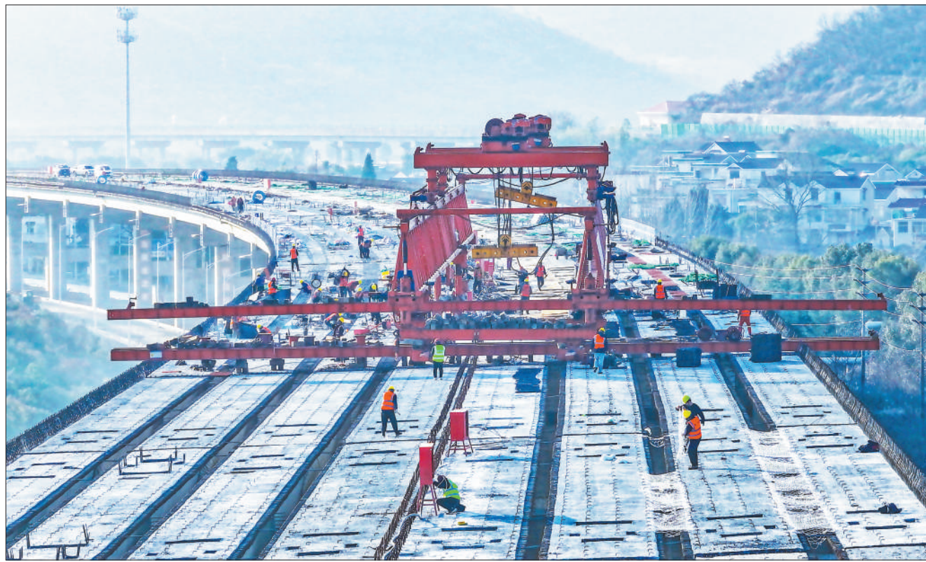
近年来,安徽省芜湖市不断提升路网密度,完善城区道路交通,方便群众出行。图为芜湖市繁昌经济开发区S334快速化通道施工现场,工人们正在施工作业。
