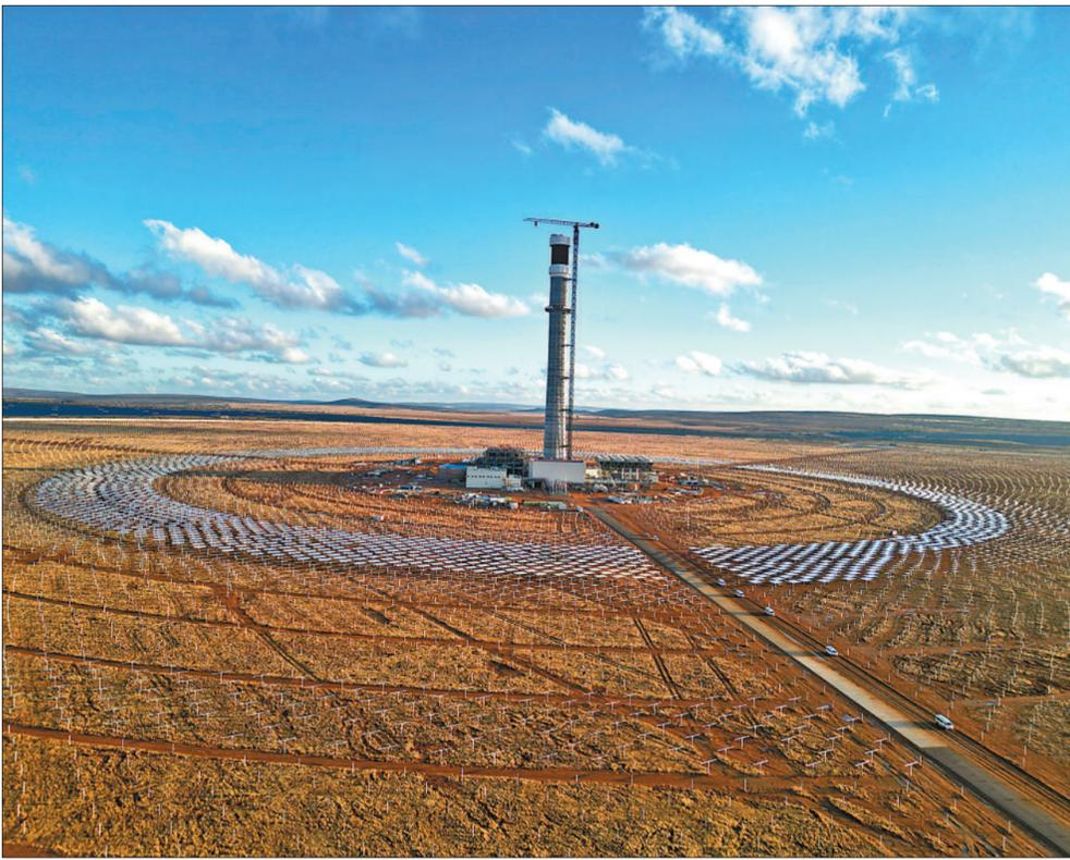
南非红石100兆瓦塔式光热太阳能项目是撒哈拉以南非洲首个熔盐光热太阳能项目,由中国电建下属山东电建三公司承建。该项目设计装机容量100兆瓦,建成后每年能向南非电网输送480吉瓦时电力,满足20万户南非家庭的用电需求,对实现南非能源转型目标具有战略意义。图为南非红石100兆瓦塔式光热太阳能项目施工现场。本报记者 邹松摄
