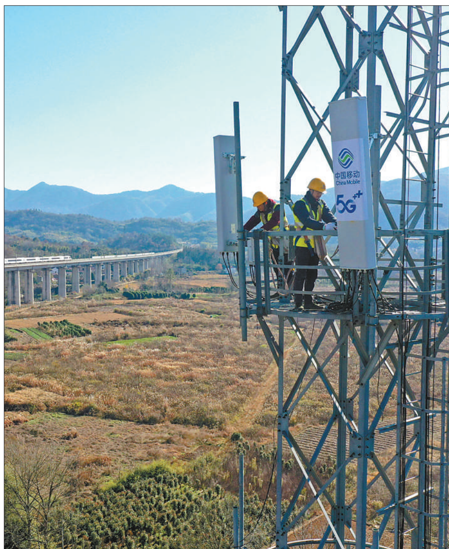
安徽移动铜陵分公司施工人员在合福高铁（铜陵段）沿线通信基站上调试5G专网设备。过仕宁摄（人民视觉）
