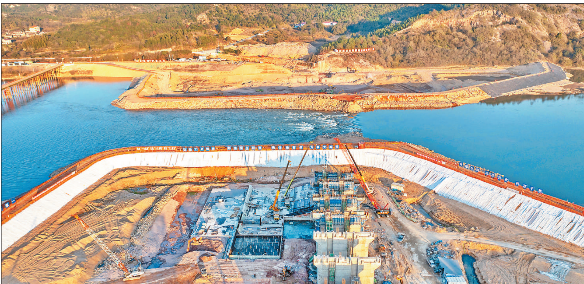
1月14日,江西省抚州市金溪县洪湾镇,疏山水利枢纽工程正加紧施工。该项目建成后,将进一步提升当地农业灌溉、安全供水等能力,助力农业生产。 邓兴东摄(影像中国)
