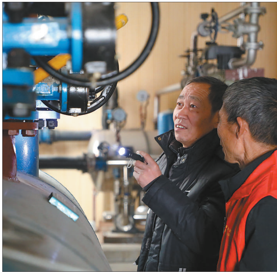
山东省滨州市惠民县何坊街道一小区内，物业管理员在查看供暖系统运转情况。 初宝瑞摄(人民视觉)
