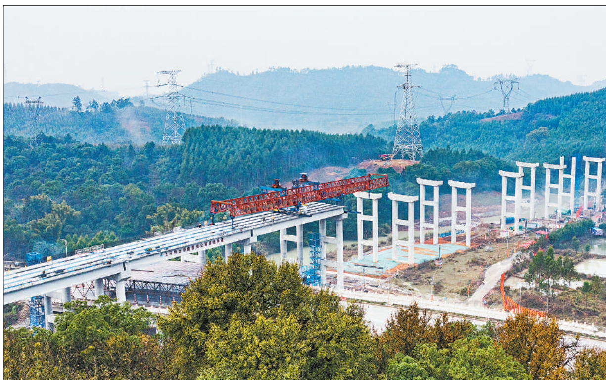
1月14日，广西壮族自治区贺州北过境线高速公路项目飞马特大桥正在施工建设。飞马特大桥全长1089米，是贺州北过境线高速公路项目控制性工程，计划于今年2月份实现半幅贯通。贺州北过境线项目建成后将进一步完善广西高速公路网络，推动沿线经济发展。
