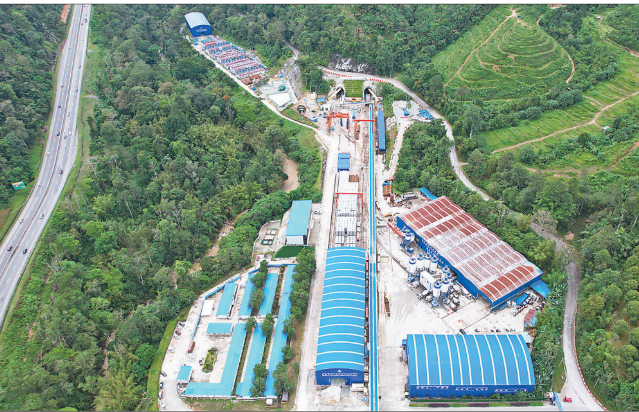
马来西亚东海岸铁路项目是中马两国共建“一带一路”重点项目，由中国交通建设集团有限公司承建。铁路全长600多公里，被视为连通马来西亚东西海岸的“陆上桥梁”，建成后将极大改善沿线地区互联互通水平，带动马来西亚经济发展。图为项目的控制性工程——云顶隧道施工作业现场。
