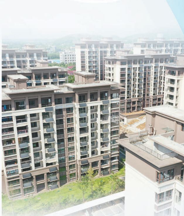
图①：陕西铜川市达美轮毂有限公司生产线。图②：安徽铜陵市狮子山独立工矿区移民安置点青泽居小区。图③：宁夏石嘴山市惠农区采煤沉陷区绿化治理后，变为如今的“七彩园”公园。
