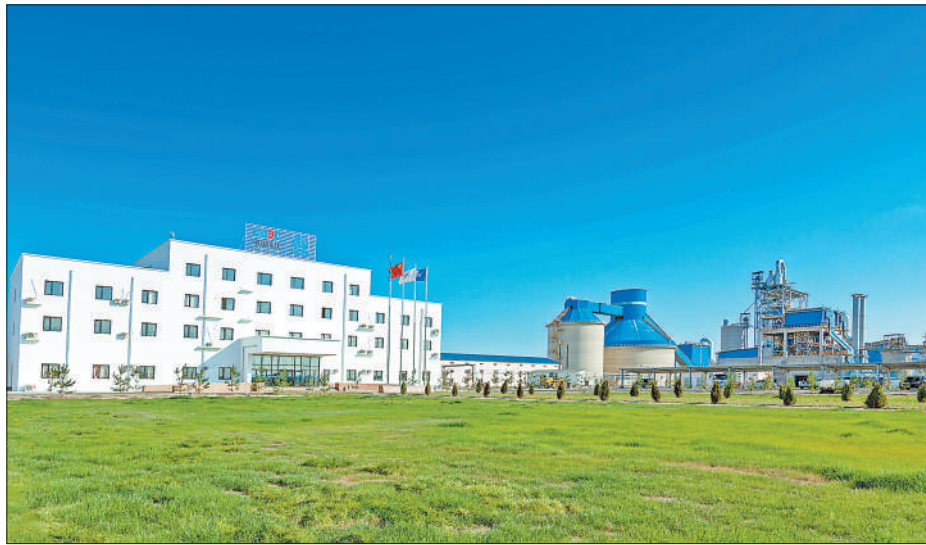
近年来,中国与中亚国家开展了一系列卓有成效的务实合作,为地区经济复苏注入动力。图为中哈产能合作重点项目——中国能建葛洲坝哈萨克斯坦西里水泥项目,该基地位于哈萨克斯坦西南部,主要生产通用水泥和油井水泥。
