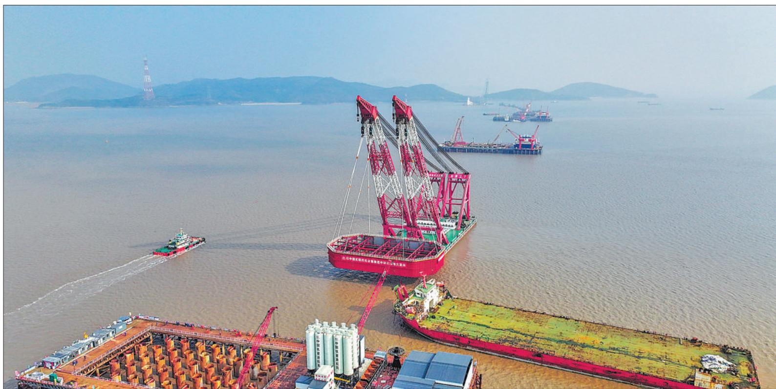
1月7日，浙江宁波舟山港六横公路大桥二期工程项目青龙门大桥首个主墩承台钢吊箱正在吊装施工。青龙门大桥双主跨756米，横越青龙门水道，连接佛渡岛和梅山岛两座岛屿。当日，青龙门大桥首个主墩承台钢吊箱完成下放，标志着青龙门大桥正式进入海上主墩承台施工阶段。
