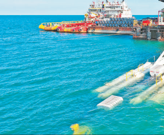
1月5日，由中国石油管道局承建的印度尼西亚拉维拉维项目52英寸海底管道拖拉头准确抵达登陆点，标志着世界最大口径海底原油管道长距离岸拖施工圆满完成。
