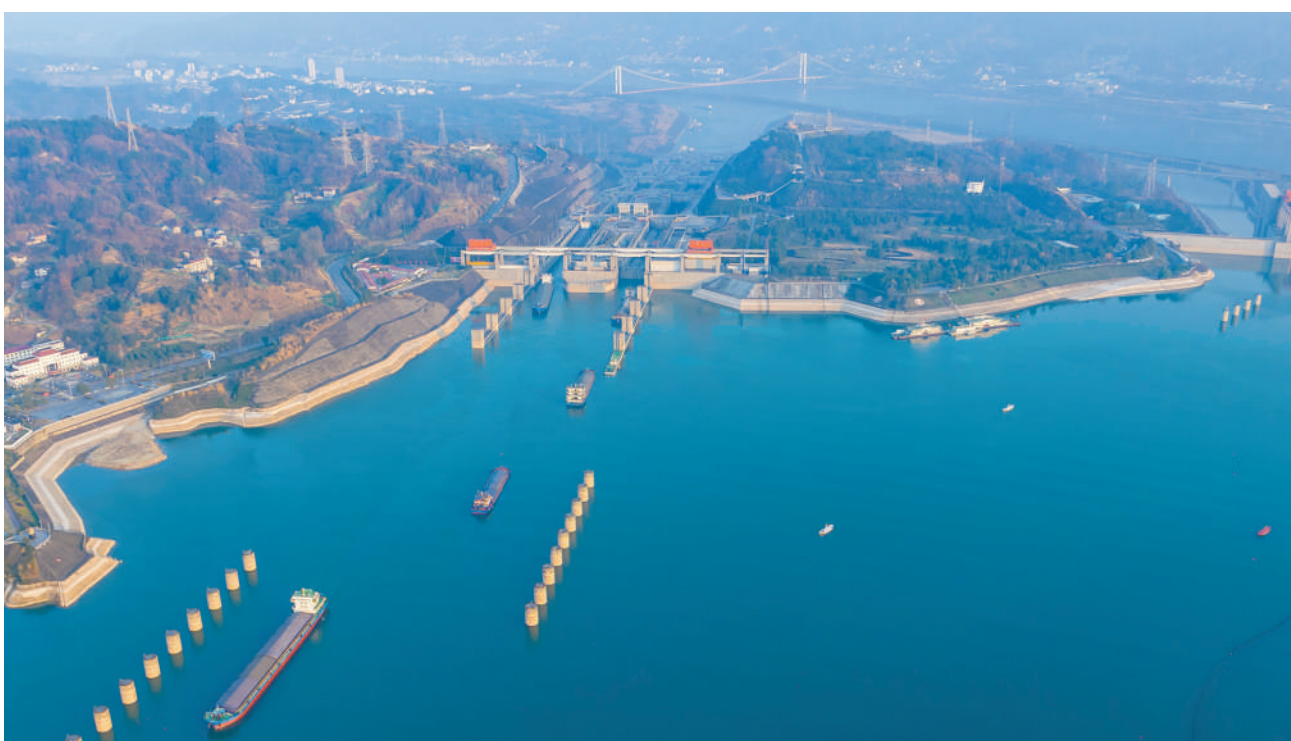
日前,长江三峡通航管理局发布数据显示:2023年三峡枢纽航运通过量达1.74亿吨,同比增长8.77%,创历史新高。其中,三峡船闸运行11066闸次,通过量1.69亿吨;三峡升船机运行4614厢次,通过量478.59万吨,护航旅客超220万人次。黄金水道航运效益进一步发挥。图为1月4日船舶行驶在三峡大坝上游三峡双线五级船闸引航道。(郑家裕摄(人民视觉))
