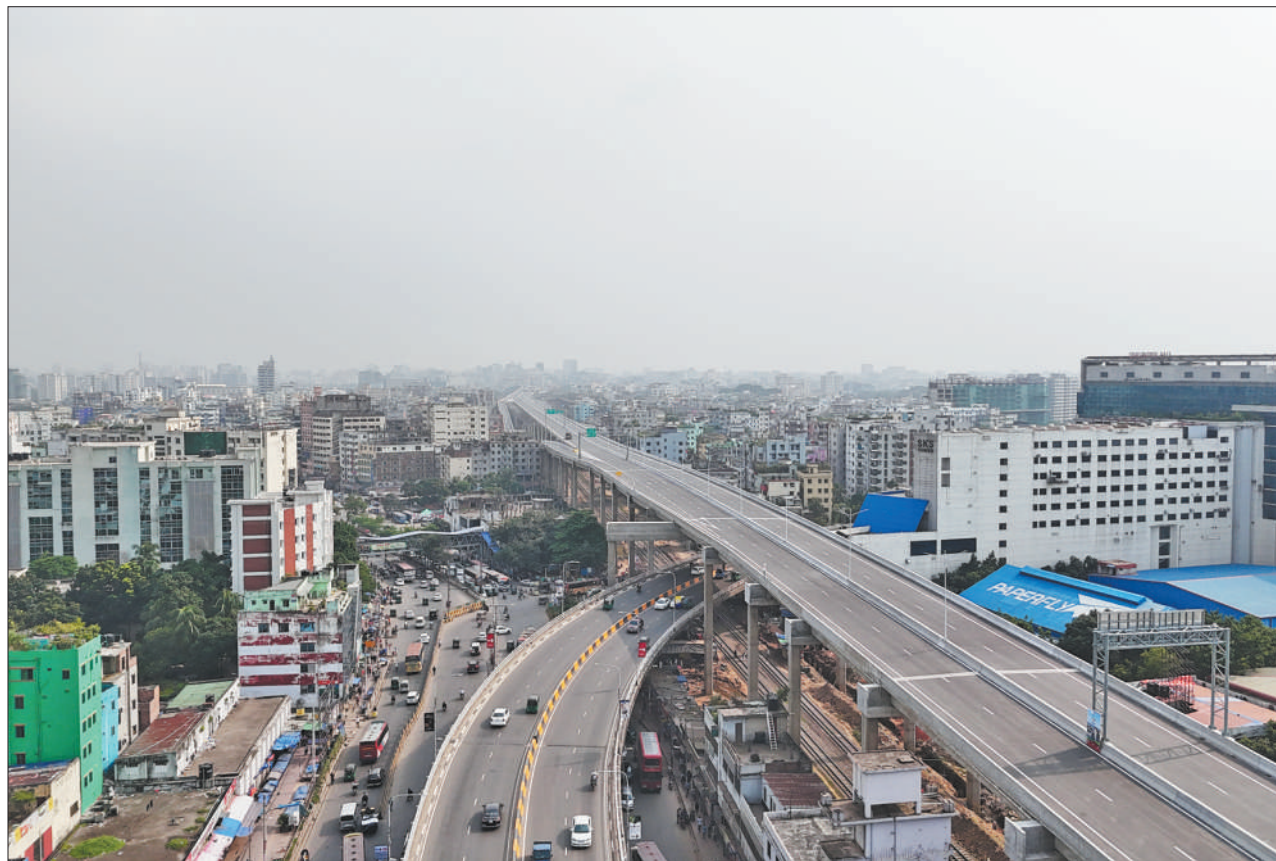
孟加拉国达卡机场高架快速路项目（一期）。
