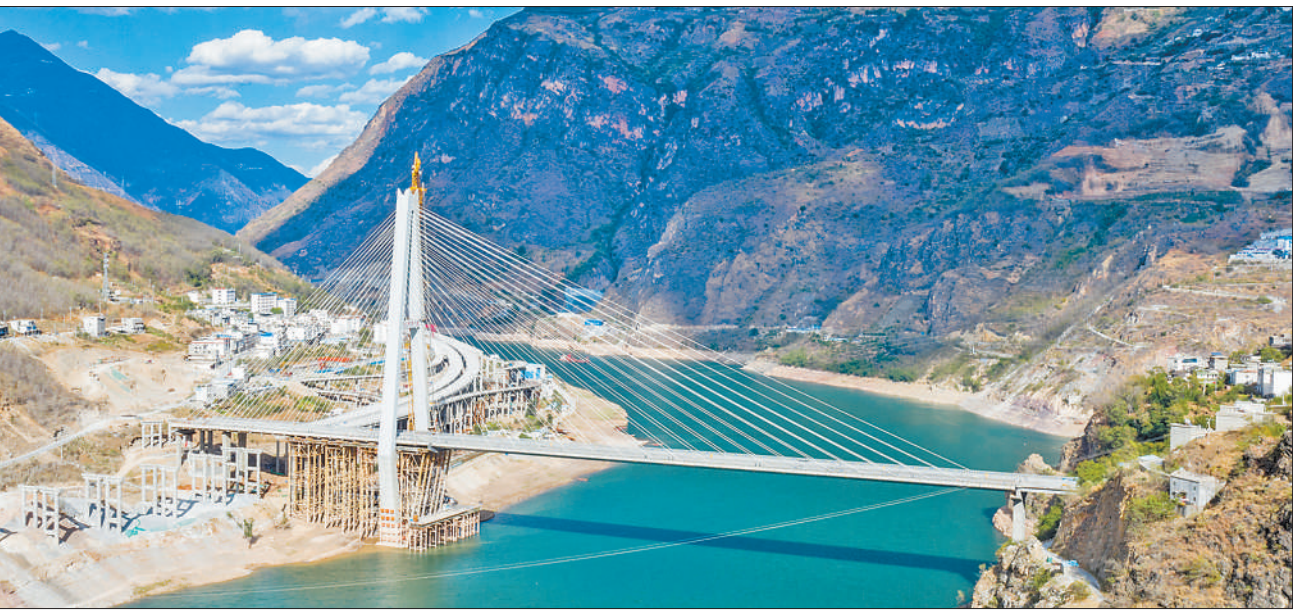
1月3日,贵州都匀市至云南香格里拉市高速公路(以下简称“都香高速”)云南昭通段全线建成通车,西南地区新增一条连接川黔滇三省的高速公路。都香高速云南昭通段全长97公里,通车后,从云南昭通市昭阳区到四川金阳县的通行时间从6小时缩短至约1小时。图为连接川滇两省的都香高速金沙江特大桥。 本报记者 李茂颖文 韩世江摄(人民视觉)
