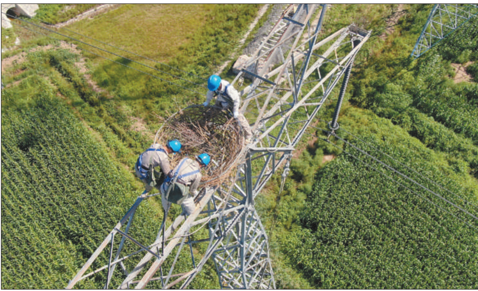
国家电网工作人员在输电铁塔上的安全区域安装人工鸟巢。
