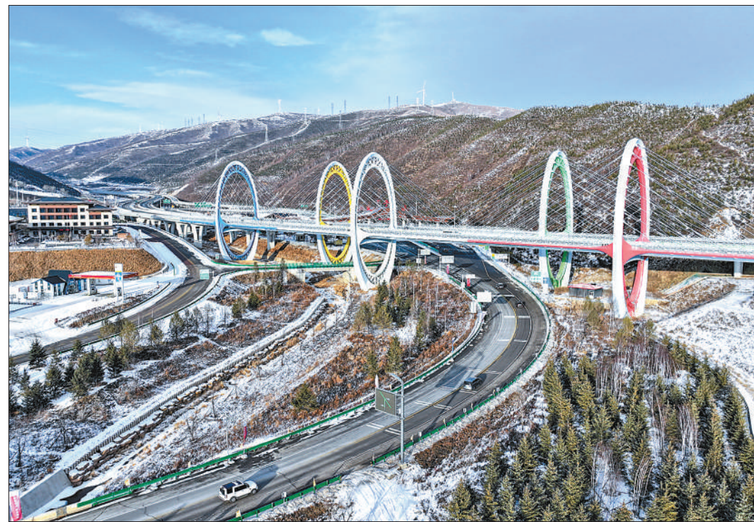
近日,在河北省张家口市崇礼区,冬奥冰雪“五环桥”在白雪映衬下美丽壮观。冬奥冰雪“五环桥”是延崇高速太子城互通主线一号桥,是进出崇礼冬奥村的标志性建筑。
