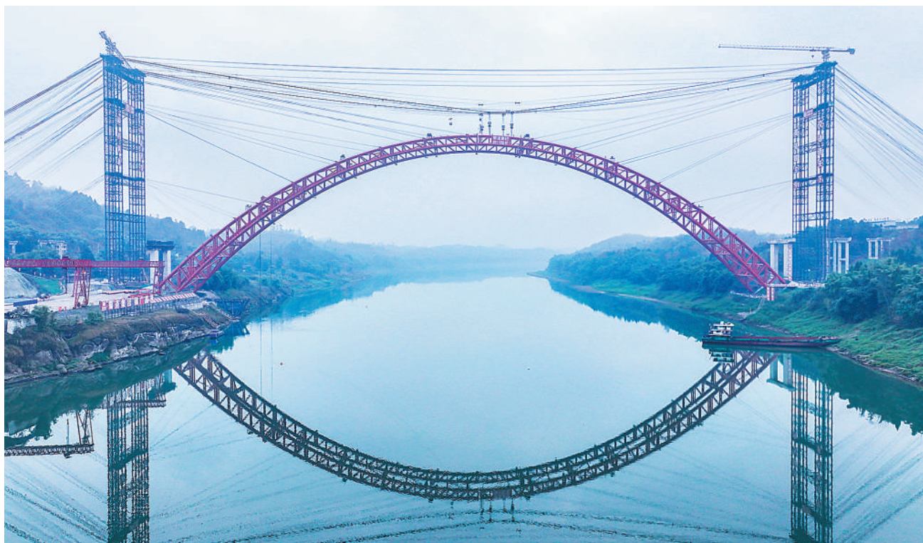
1月2日，镇（巴）广（安）高速公路白马渠江特大桥顺利完成钢管拱合龙。镇广高速公路北连陕西省汉中市镇巴县，南连四川省广安市广安区，白马渠江特大桥是镇广高速公路的重点控制性工程。
