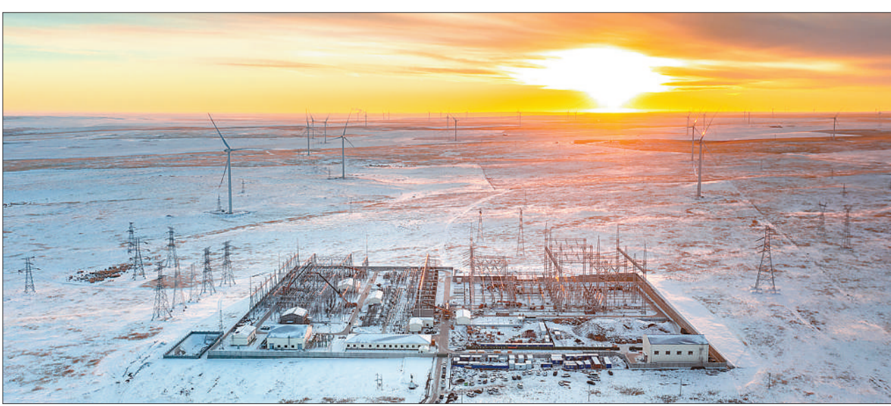
12月20日，内蒙古自治区锡林郭勒盟400万千瓦新能源送出工程顺利投运。该工程是国家第一批以沙漠、戈壁、荒漠地区为重点的大型风电光伏基地建设项目，也是内蒙古特高压能源保供重点项目。张 彬 马 超摄影报道
