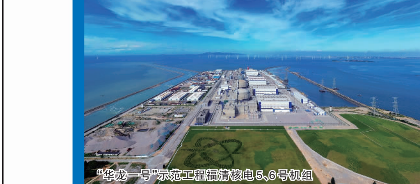
“华龙一号”示范工程福清核电5、6号机组
