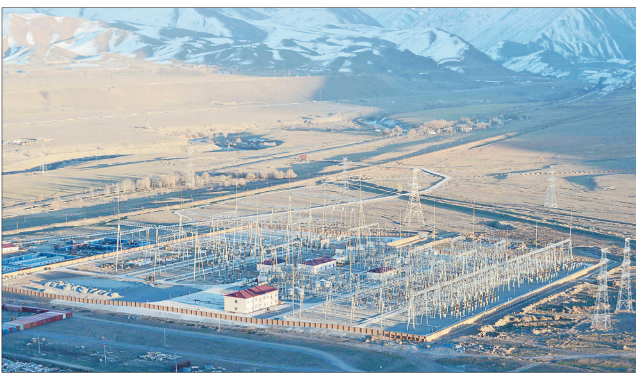
达特卡—克明输变电项目是中国与吉尔吉斯斯坦共建“一带一路”重点项目之一，由中国进出口银行提供融资支持，特变电工股份有限公司承建。项目建成投运后，连接了吉南北电网，保障了电力供应安全。图为位于吉北部城市克明的500千伏变电站远景。 朱海龙摄
