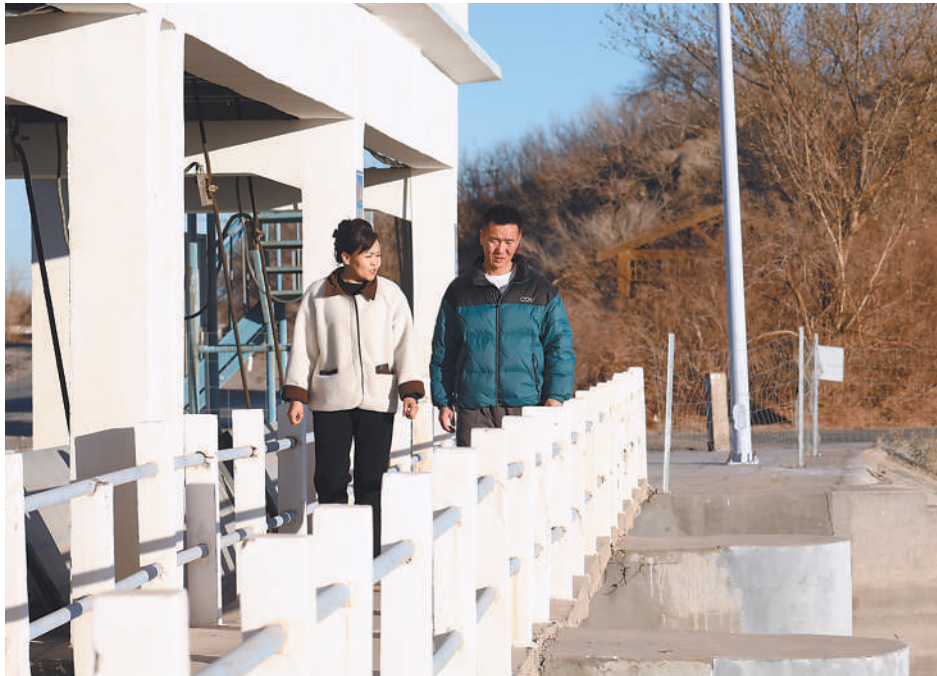
上图:敖云塔娜(左)在检查水闸口。左下图:敖云塔娜在巡护河道。
