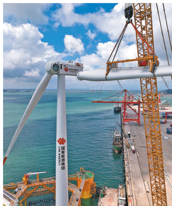
平台在进行风机第二根叶片吊装作业。 林启鑫摄
