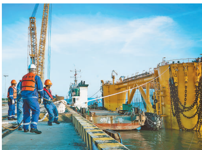
福建平潭金井码头，工作人员在对平台进行靠泊系缆作业。 林启鑫摄
