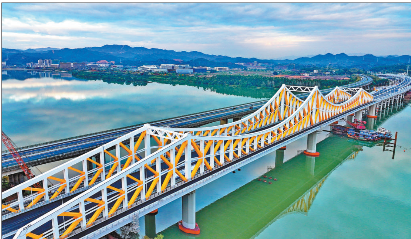
12月10日，江西省赣州市螺溪洲大桥进入施工收尾期，预计12月底满足通车前的各项条件。跨越赣江的螺溪洲大桥是国内首个采用全K型桁架结构的大跨径桥梁。
