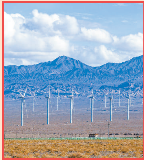
甘肃酒泉玉门市,广袤戈壁上的风机。 侯崇慧摄(人民视觉)
