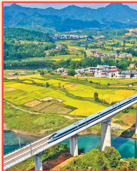
动车组列车经过贵南高铁盘清水河双线特大桥。 肖 伟摄(影像中国)
