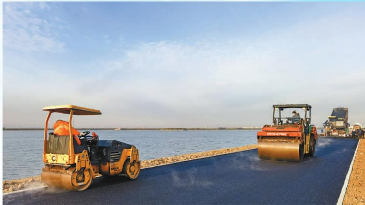
天津市西青区水务部门组织对鸭淀水库外围堤防进行改造加固,提升水库防洪保安全能力。
