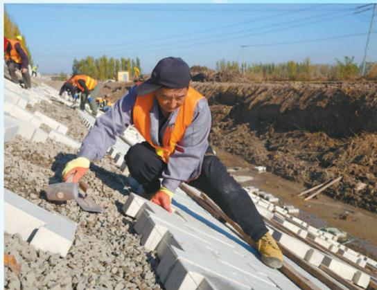
工人在河北省唐山市丰南区王兰庄镇彭家庄村灌溉水渠护坡加固工地施工。
