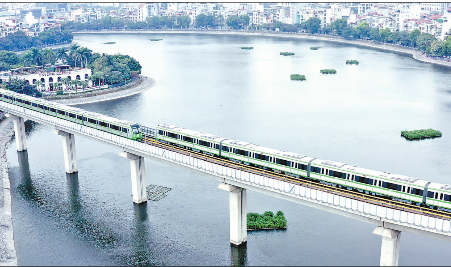
越南首都河内的吉灵—河内线是该国首条开通运行的轻轨，由中国中铁六局总承包建设，是中国共建“一带一路”倡议和越南“两廊一圈”对接的标志性项目。轻轨线路全长约13公里，自投入商业运营以来，轻轨安全运输旅客近1900万人次，极大方便了当地居民出行，促进了河内经济发展。图为轻轨线上两列列车在会车。张广庆摄
