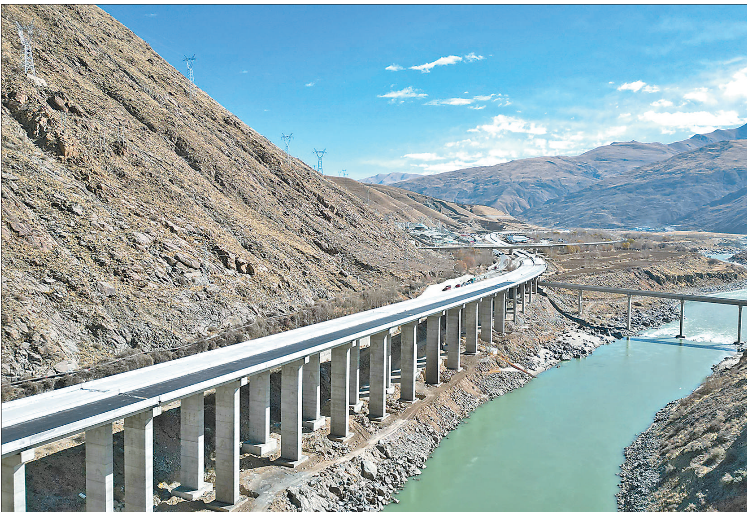
图为12月5日拍摄的拉日高速公路卡巴2号特大桥。
