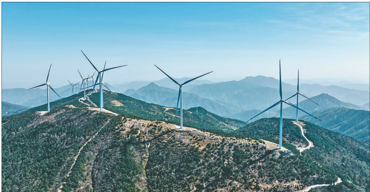
位于浙江台州市黄岩区西部山区海拔1000米处的大寺基山脊光伏风电场，利用风力资源，促进节能减排，缓解供电压力。据了解，风电场可提供8000万千瓦时绿电，每年节约标煤30多万吨。浙江电力利用自身优势主动服务风电场，引导绿色低碳生产生活方式，实现生态保护和可持续发展。（蔡 婷摄（影像中国））
