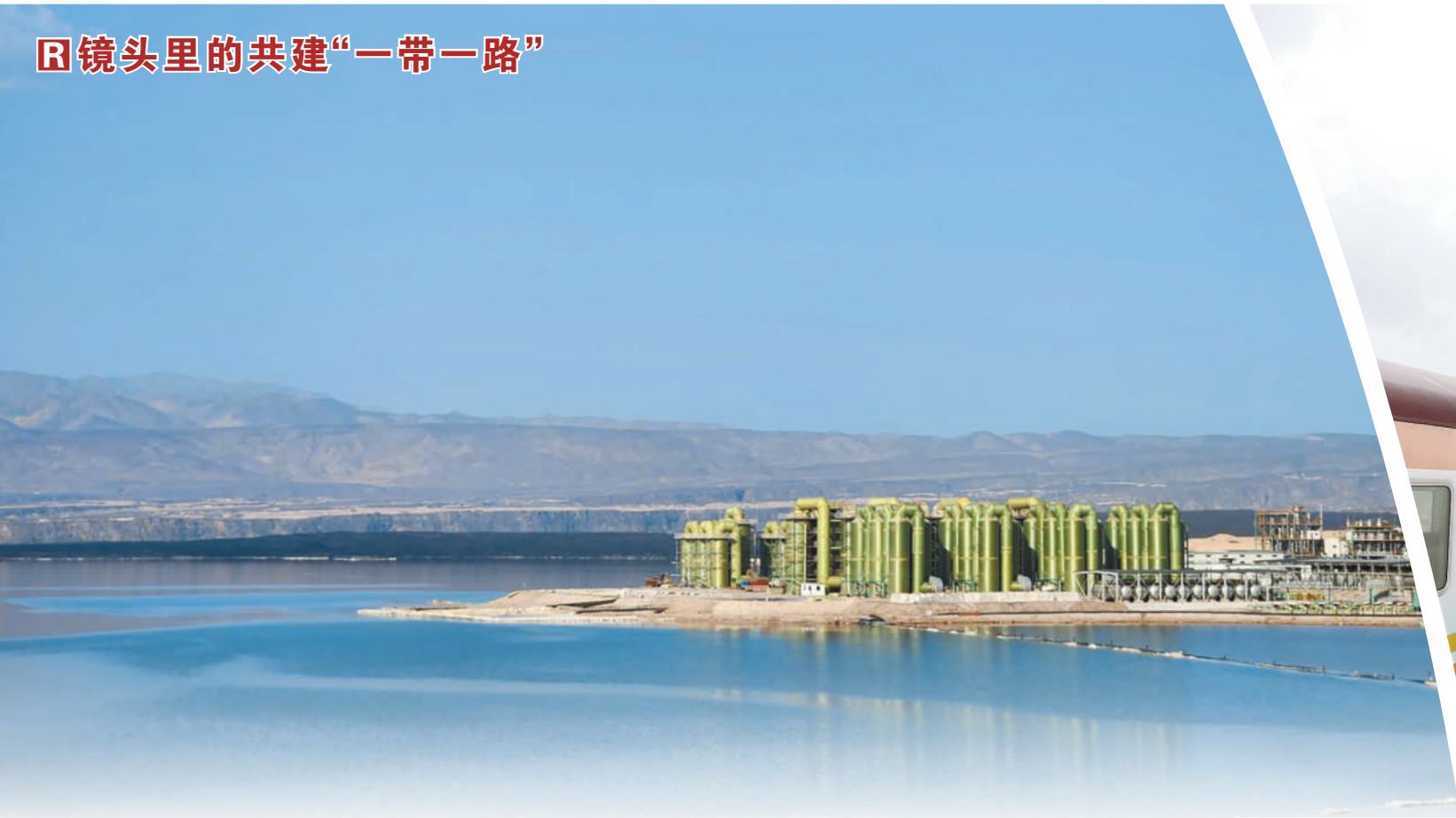
▲阿萨尔盐湖位于吉布提中部,是吉布提具有商业开发价值的最重要自然资源之一。自2017年起,中交产业投资控股有限公司吉布提盐业公司和山东海王化工股份有限公司共同开发阿萨尔盐湖氯化钠和氯化钙项目。该项目的实施推动了吉布提工业化发展,改善了当地居民生活条件,为吉布提经济发展、出口创收和增加就业作出了贡献。图为阿萨尔盐湖氯化钠项目远景。 本报记者 黄炜鑫摄
