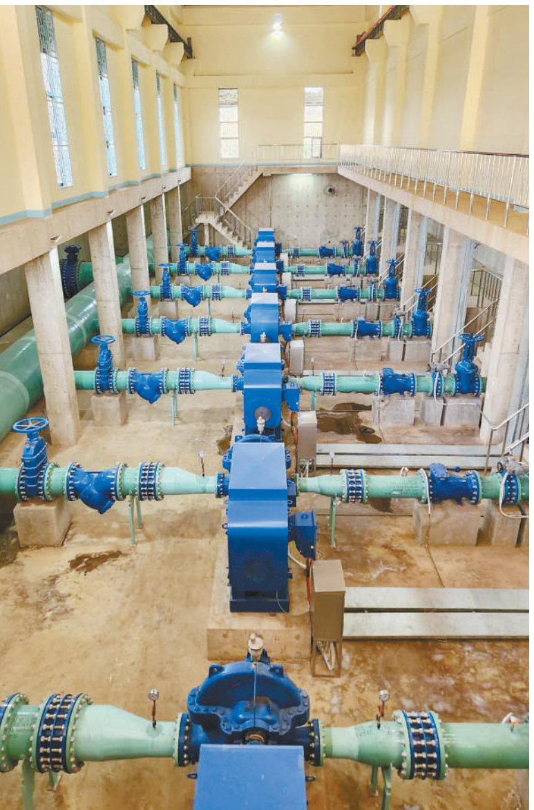
▲坦桑尼亚阿鲁沙新供水系统项目由中国电建市政建设集团有限公司承建。项目设计日供水量为12.5万立方米/天,可满足阿鲁沙40万人的用水需求。项目建成后将极大地改善阿鲁沙市区的供水短缺问题,对推动当地经济发展、增进民生福祉具有重要作用。图为阿鲁沙新供水系统项目5号提升泵站内部。 本报记者 黄炜鑫摄
